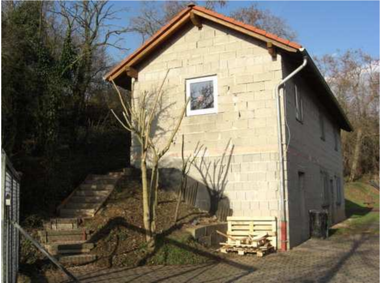
Bau der Zwischendecke
