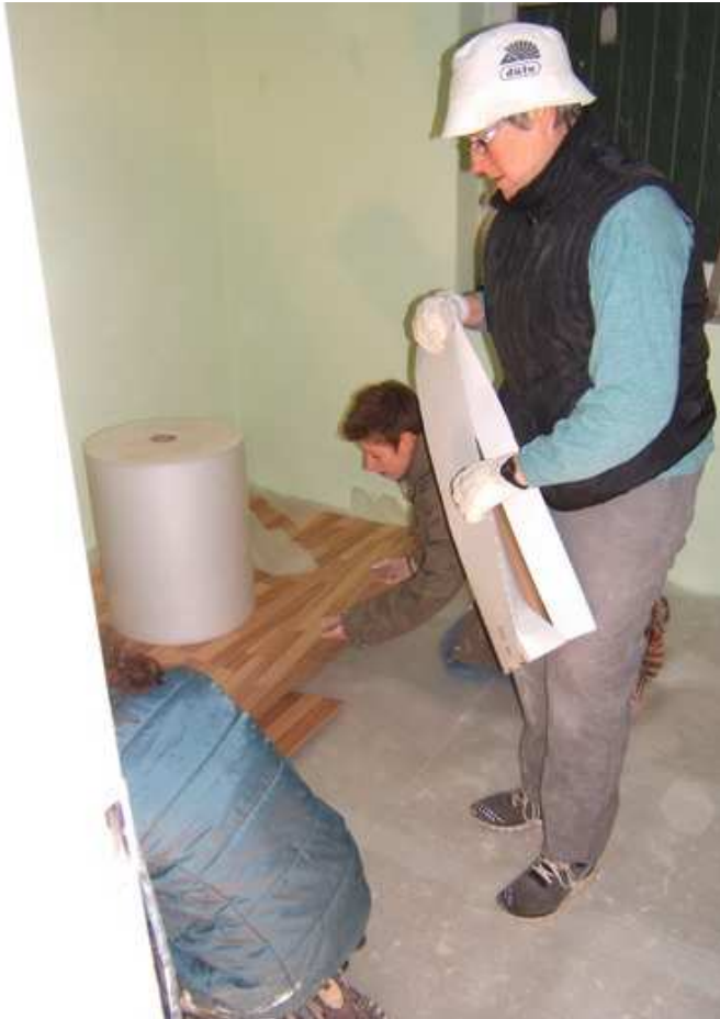
Fußbodenverlegung
